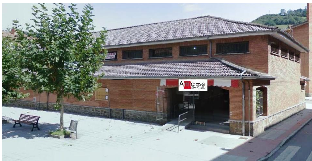
Local “La Placina” donde se prevé instalar el nuevo Comedor Solidario
